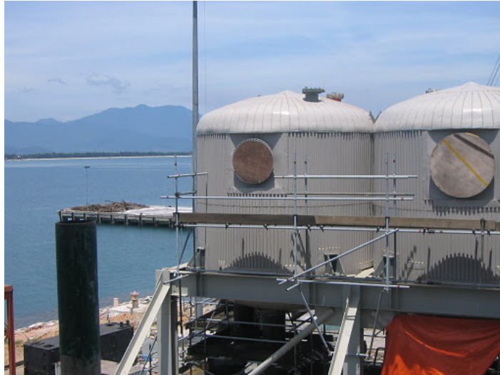
Gambar 3.5 Contoh bejana tekan yang terpasang pada struktur (Wikimedia, 2011)
