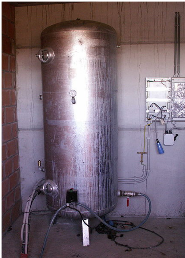
Gambar 3.6 Contoh bejana tekan yang terpasang pada sistem pemanas air (Wikimedia, 2011)
